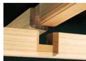
格縁 組手 (従来の組手越加工)
