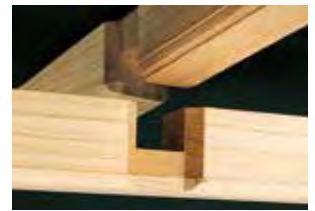
格縁 組手 (従来の組手越加工)
